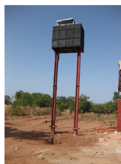
Foto 8 depósito de água
