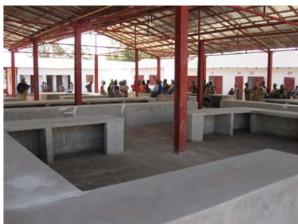
Foto 5 aspectos do hangar central
