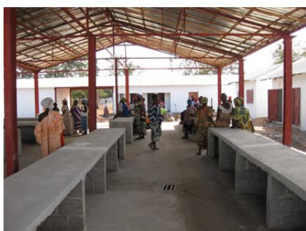
Foto 7 aspectos do hangar central
