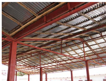
Foto 6 aspectos do hangar central
